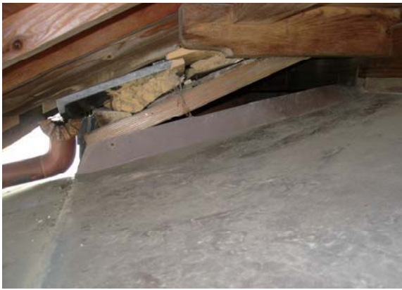
(3) 屋根裏への侵入口
