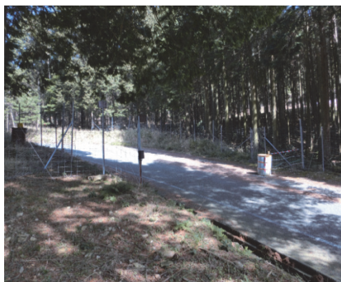
図5-1. 集落防護柵の開口部
