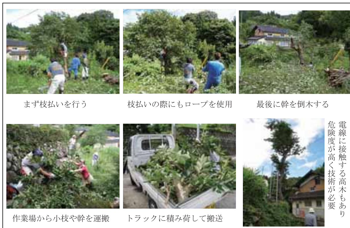
図 12 カキの木の伐採作業の様子
