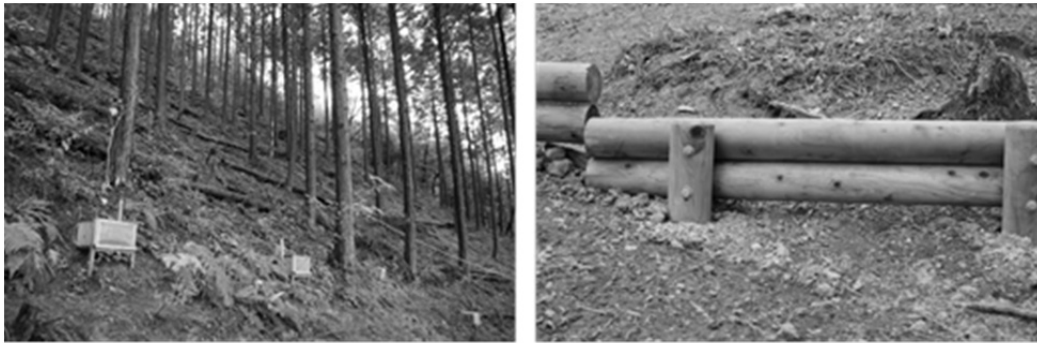
写真 7-1 間伐木を利用した筋工（左）と丸太を利用した柵工（右）
