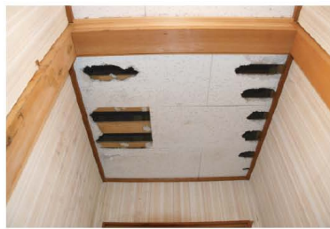
トイレ天井を破られた現況
