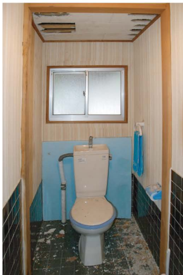
【被害現場：N氏邸、トイレ】
