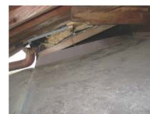
屋根裏につながる隙間
