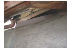
屋根裏につながる隙間
