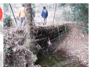
沢からの侵入防止対策
