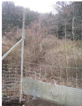
上部の飛び込み対策は有刺鉄線、下部からの侵入はトタンで対応
