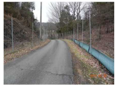
柵で封鎖できない道路は、両脇に柵を延長して対応。夜間は扉を閉めるなど開口部対策にも取り組む。
